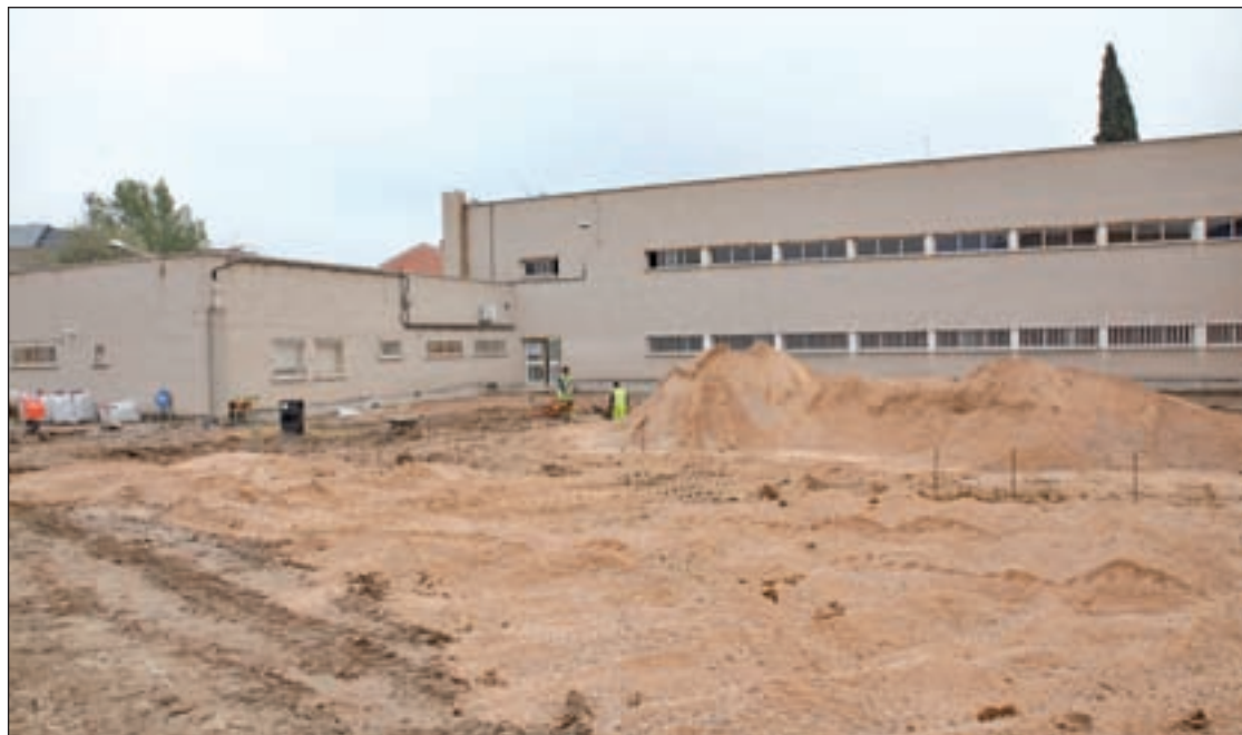
Actual estado de las obras GENTE
