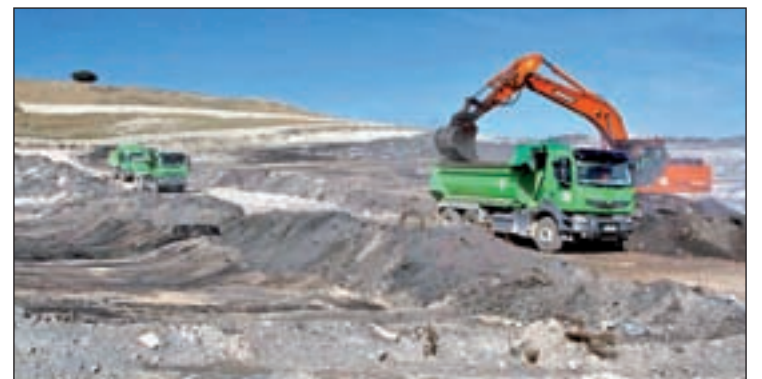
Trabajos de limpieza en el cementerio de neumáticos
