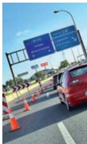
Obras en la A-5 C. M. / GENTE
