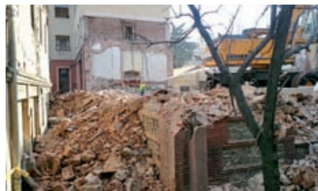
Trabajos de demolición
