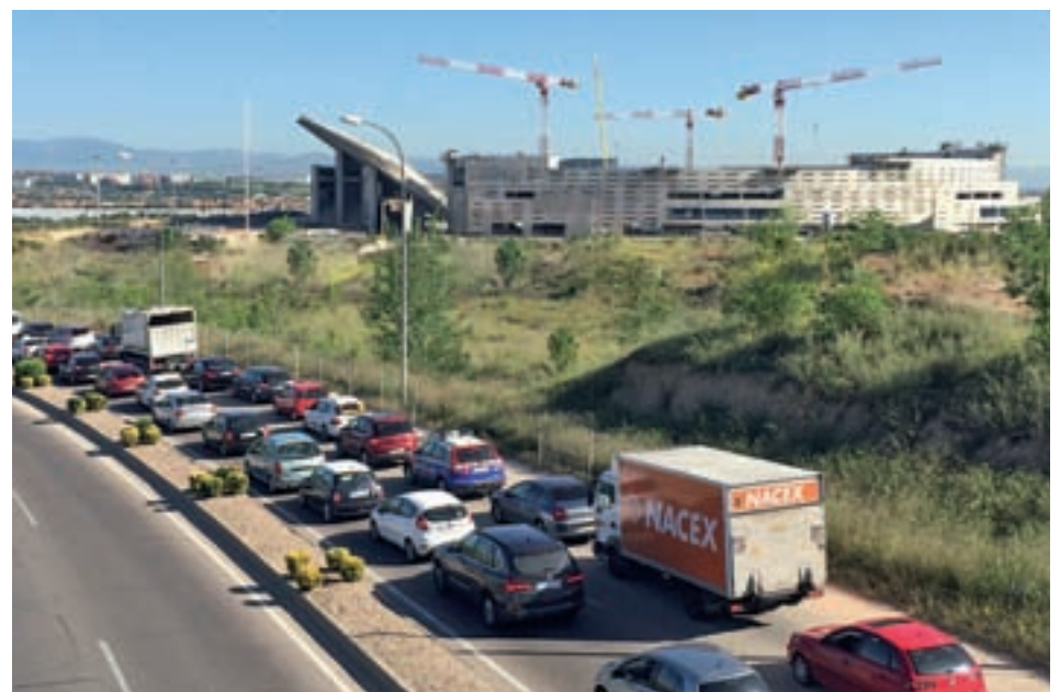
Obras en el nuevo estadio del Atlético de Madrid
