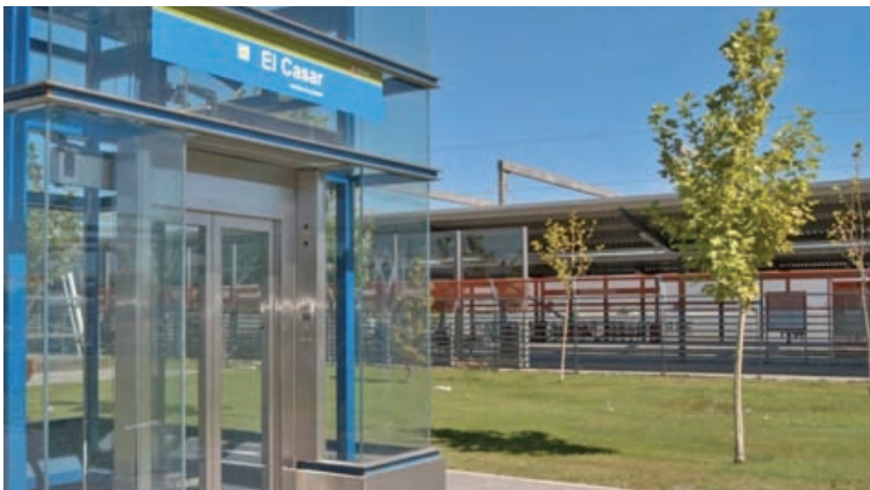
Estación de Metro de El Casar
