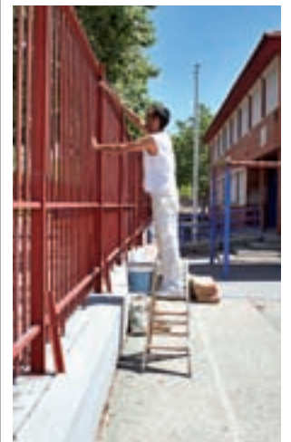
Trabajos de pintura GENTE
