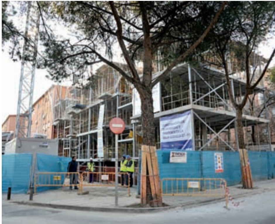
La promoción pública que se está construyendo en el barrio de San Cristóbal de los Ángeles
