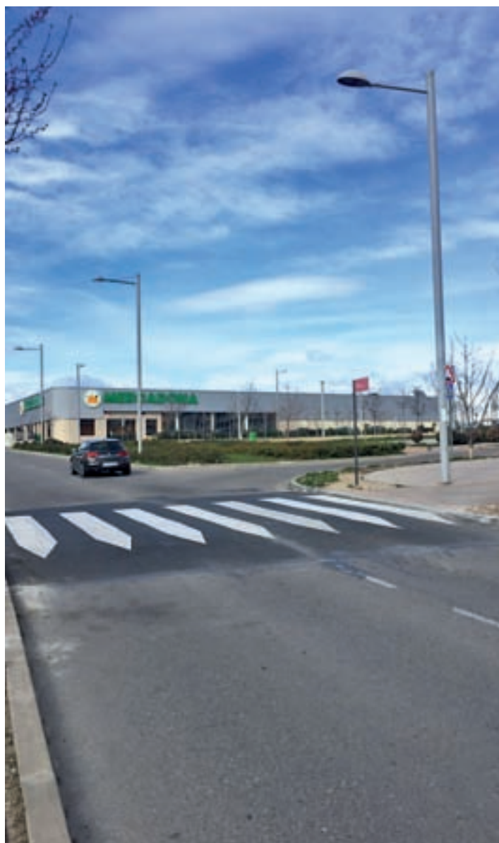
Uno de los resaltos ya rebajados en la calle Gloria Fuertes GENTE
