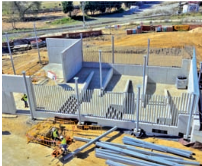
Obras del nuevo acceso a la estación de Torrejón
