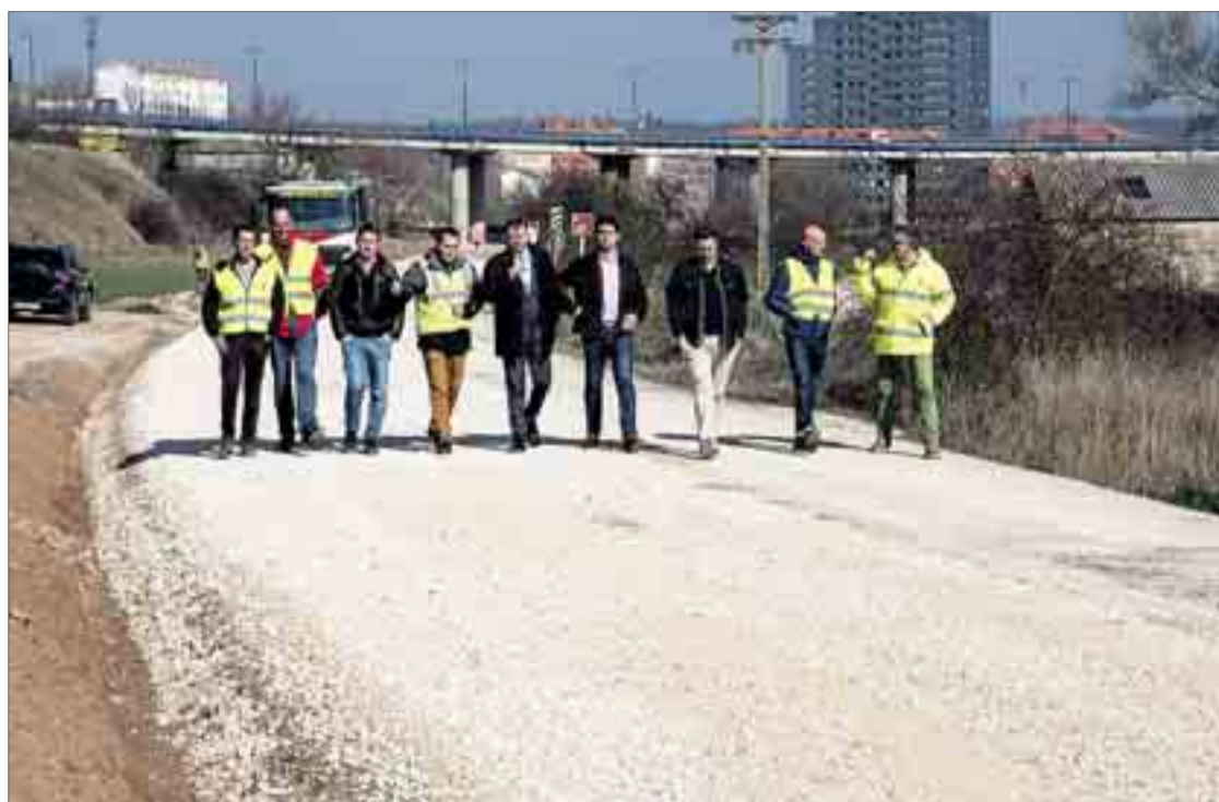
El alcalde, Javier Lacalle, visitó las obras junto al edil de Infraestructuras, Jorge Berzosa, y el portavoz socialista, Daniel de la Rosa.
