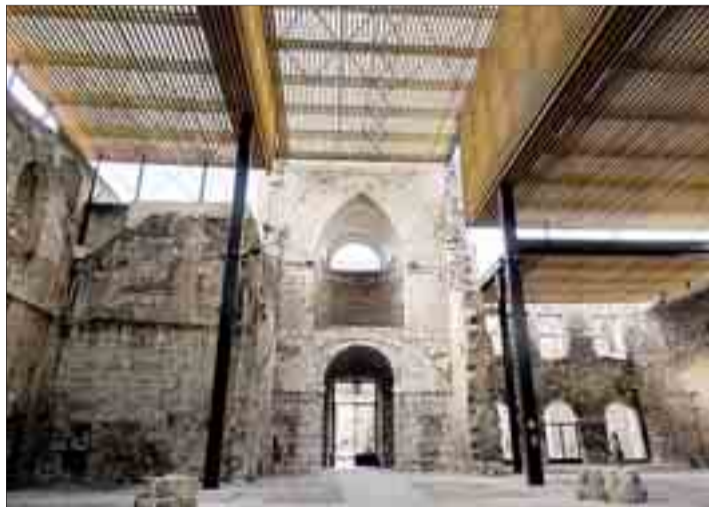
Imagen de la cubierta rehabilitada del Monasterio de San Juan.
