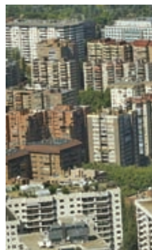
Viviendas en Madrid
