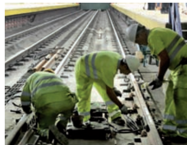
Obras en la Línea 5 de Metro
