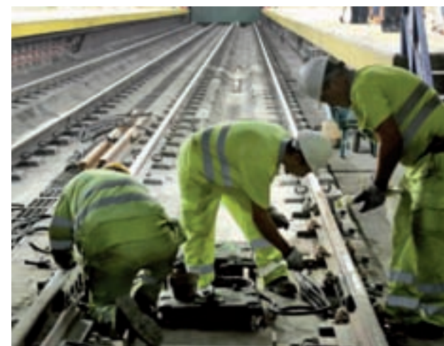
Obras en la Línea 5 de Metro
