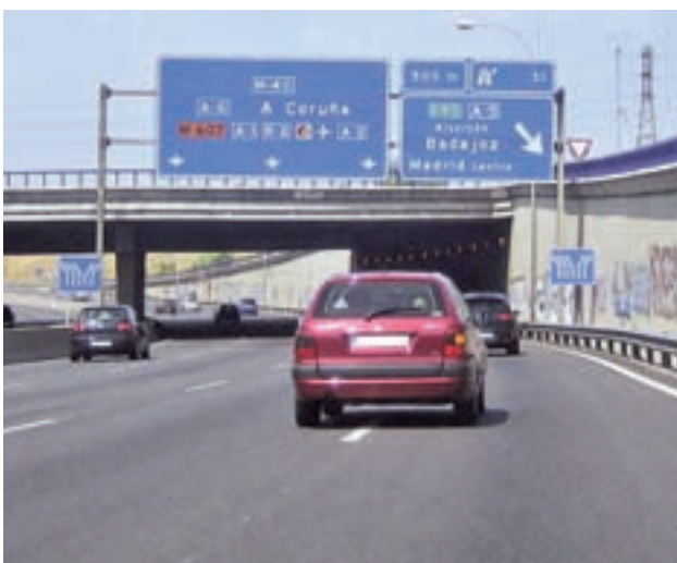
Tramo sobre el que se actuará
