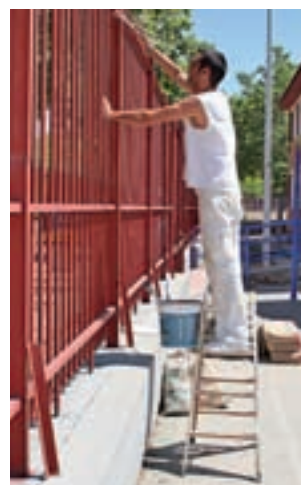
Trabajos de pintura GENTE
