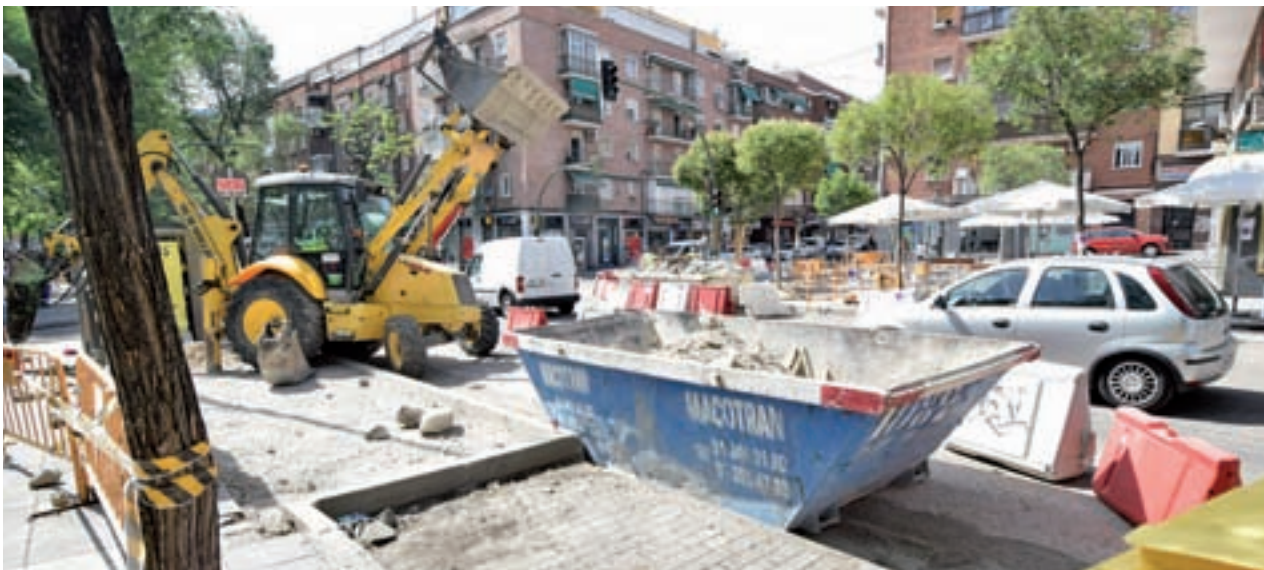
Estado actual de los trabajos en la vía pública CHEMA MARTÍNEZ/ GENTE
