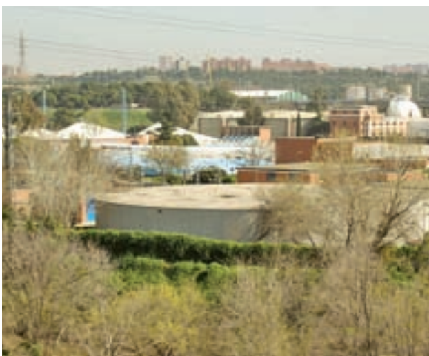
La planta de tratamiento situada en el distrito de Usera
