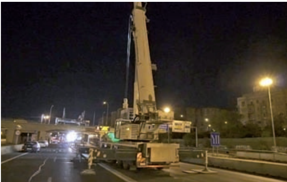
Trabajos en la avenida del Mediterráneo
