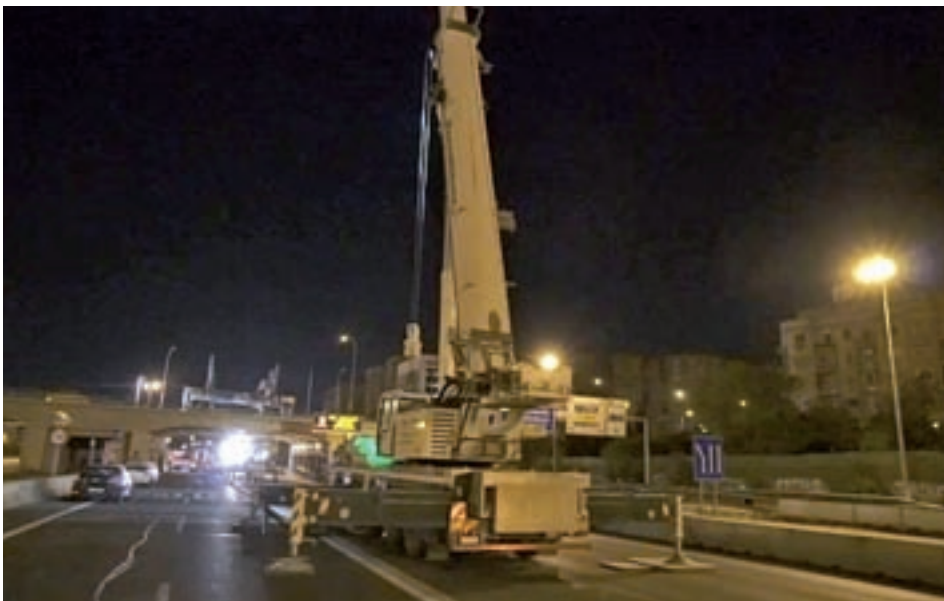
Trabajos en la avenida del Mediterráneo
