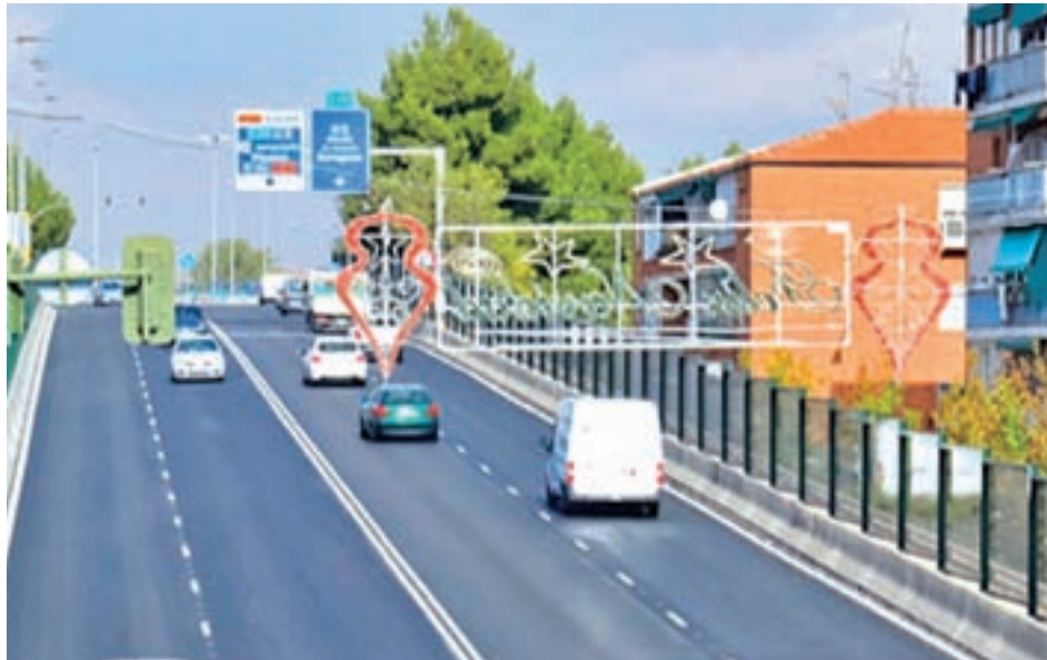
Aspecto de la zona tras las obras
