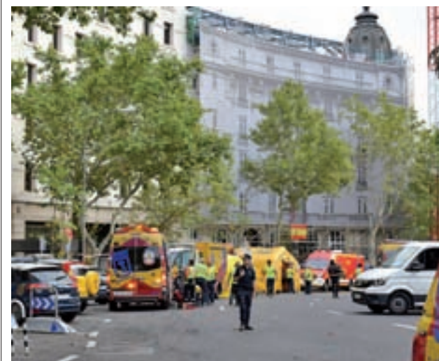
Sanitarios en el lugar del derrumbe CHEMA MARTÍNEZ / GENTE
