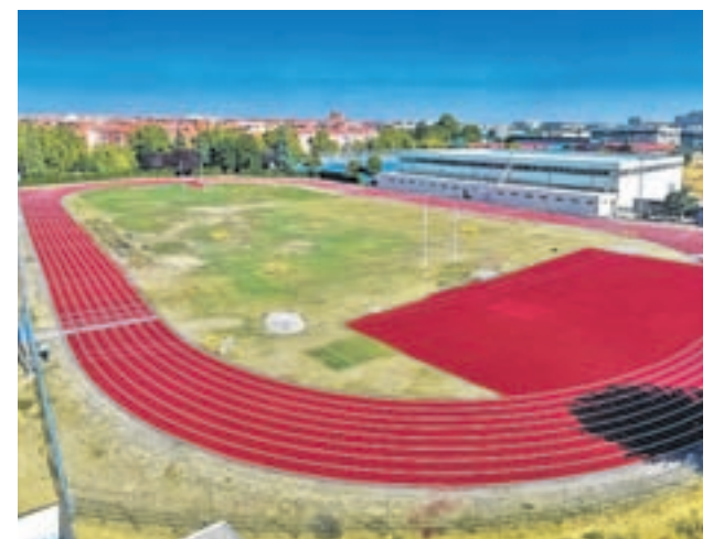
Instalación recién remodelada
