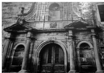
Detalle de la antigua fachada.
