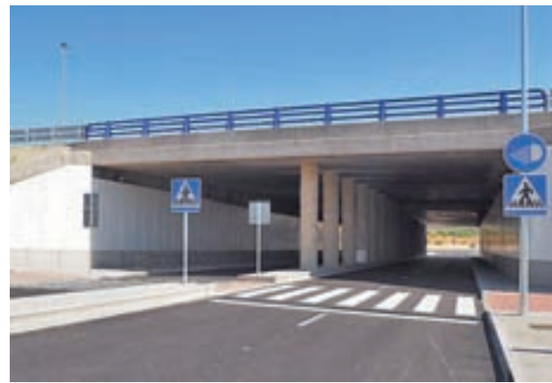
El resultado de los trabajos
