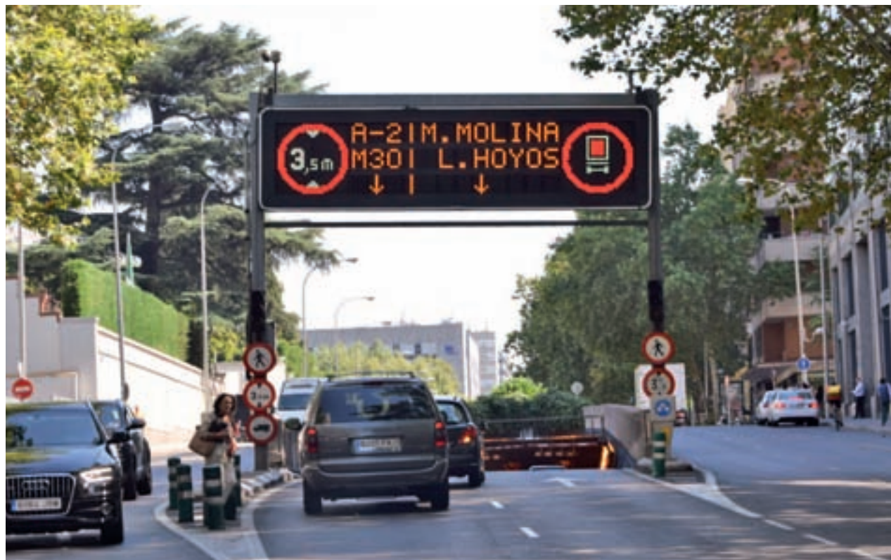
Una de las entradas al túnel de María de Molina CHEMA MARTÍNEZ / GENTE
