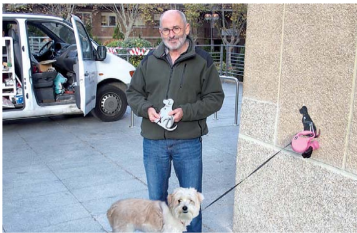
Jesús Ruiz tutor, junto a uno de los anclajes recién instalados.
