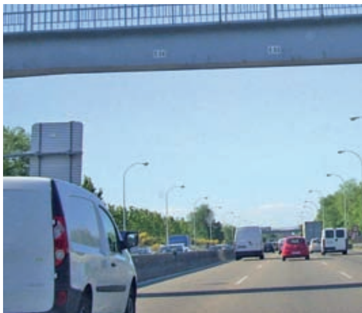
Un tramo de la autovía A-4
