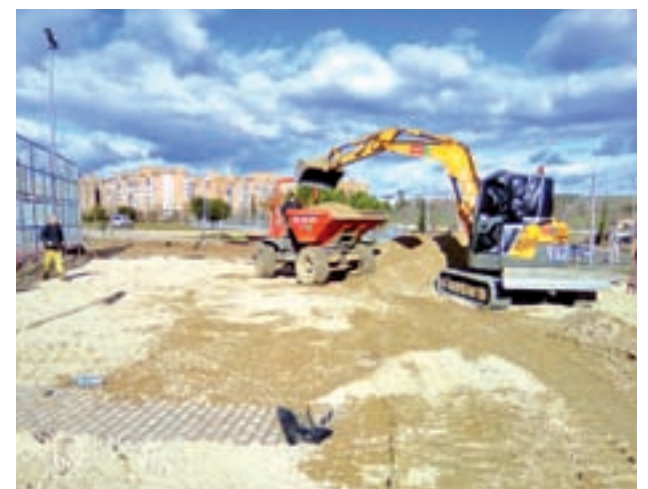
Una excavadora trabaja en la zona verde hortalina
