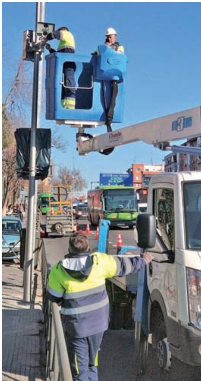
Los operarios ultiman la instalación del dispositivo @SERGIO_GFP
