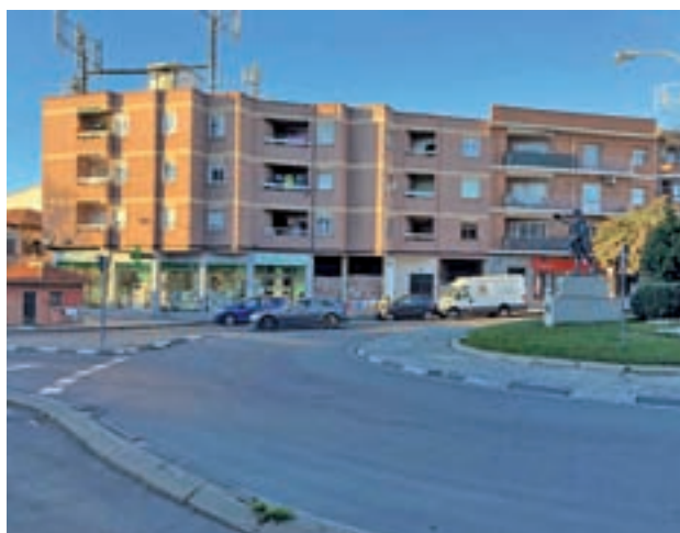
Estado actual del entorno de la rotonda
