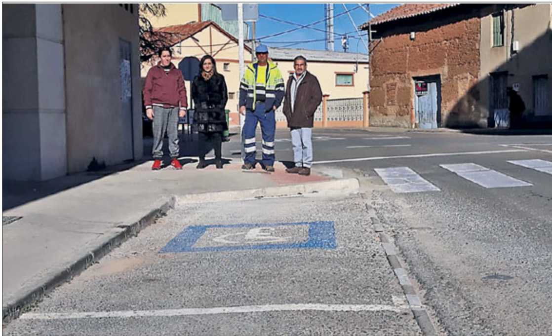
La alcaldesa de Santa María del Páramo, Alicia Gallego, visitó las obras de mejoras realizadas en la calle La Fábrica de la localidad.
