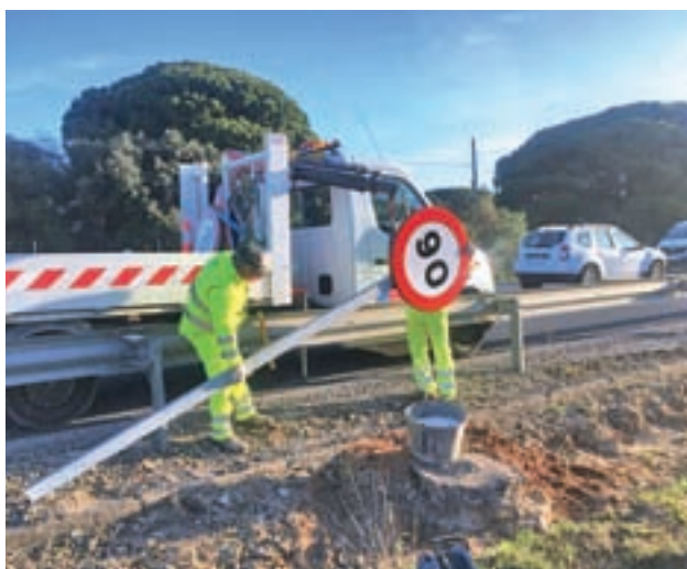
Operarios cambian una de las señales
