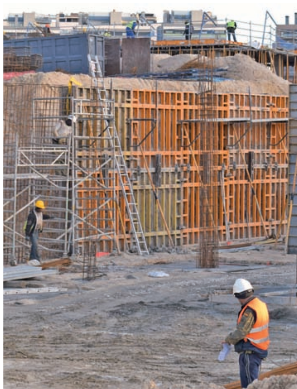
Viviendas en construcción en la Comunidad de Madrid CHEMA MARTÍNEZ / GENTE
