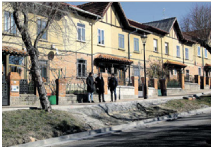
El alcalde visitó el final de las obras, junto al concejal de Infraestructuras, el jueves 14.
