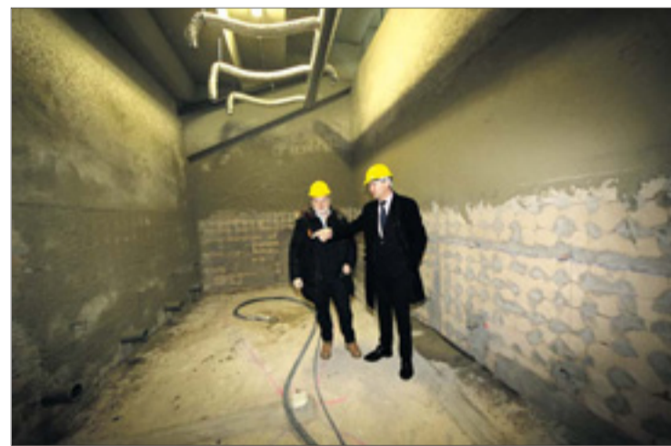
El alcalde visitó la obra de construcción de los nuevos baños del Coliseum, el miércoles 13.
