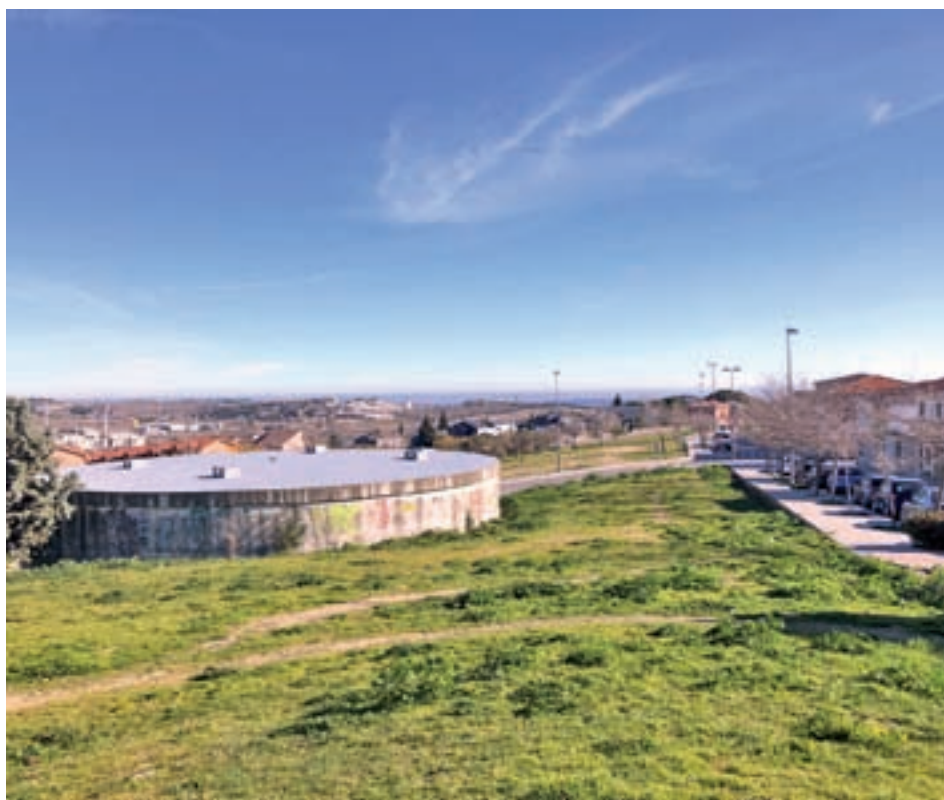
Estado actual de los trabajos CHEMA MARTÍNEZ / GENTE
