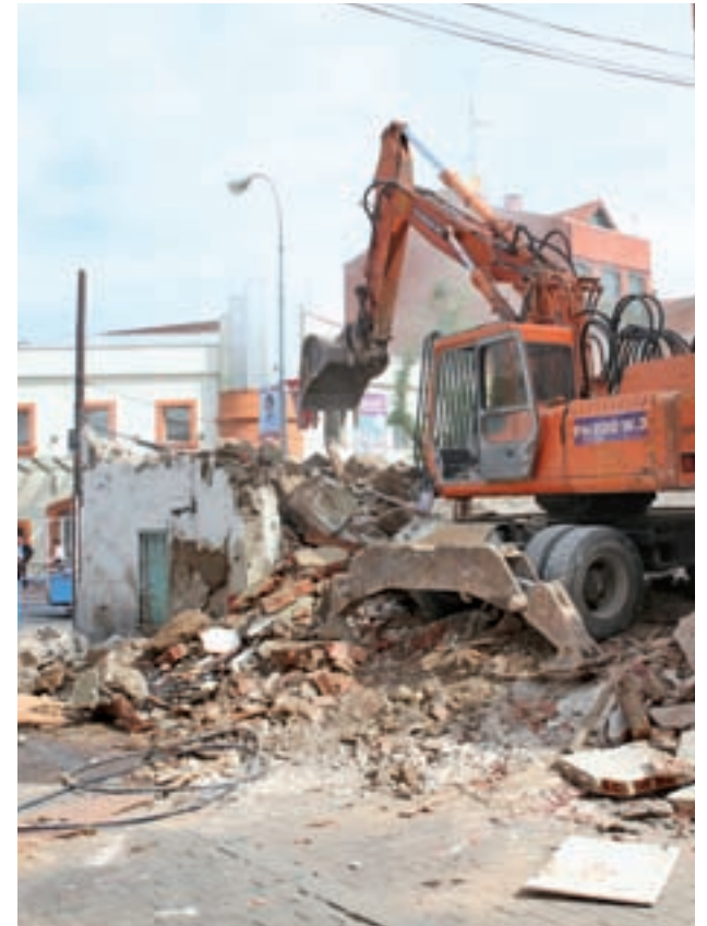
Imagen de los trabajos de derribo
