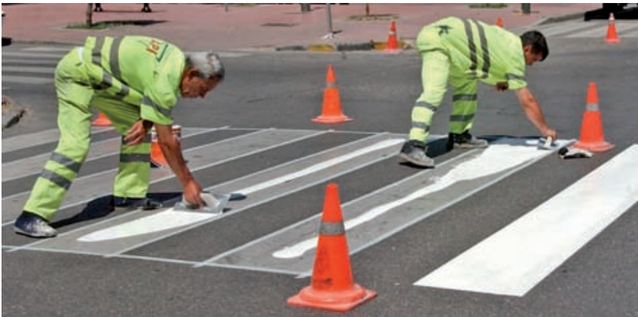
Obreros en pleno arreglo de un paso de cebra
