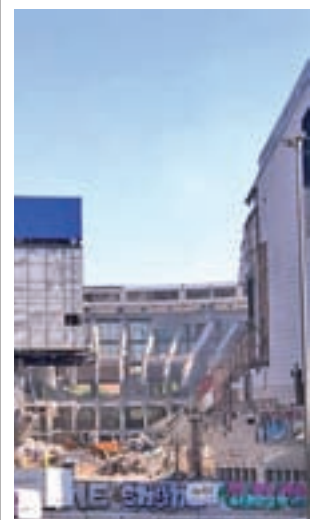
La demolición del estadio
