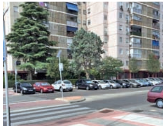
El tramo afectado se ubica entre el número 1 y el 21
