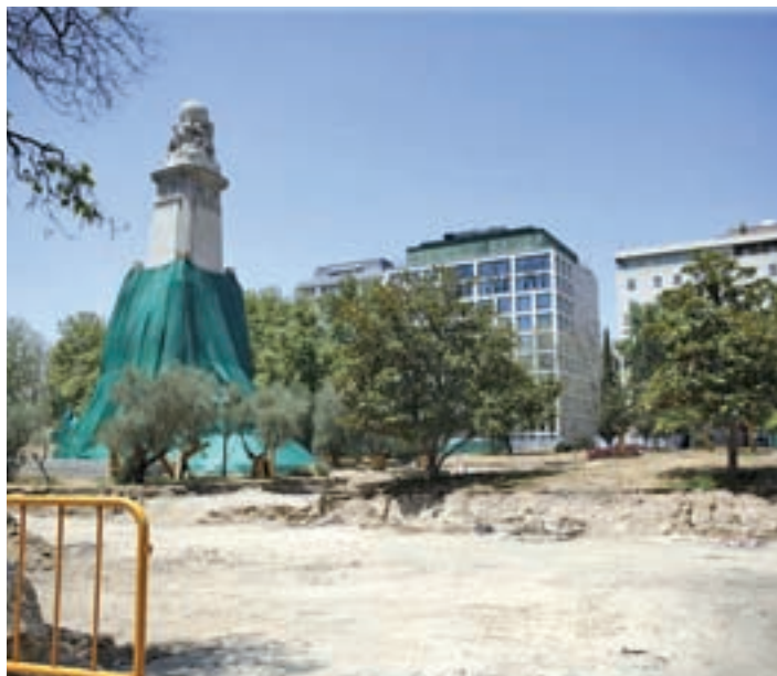
Las obras de Plaza España
