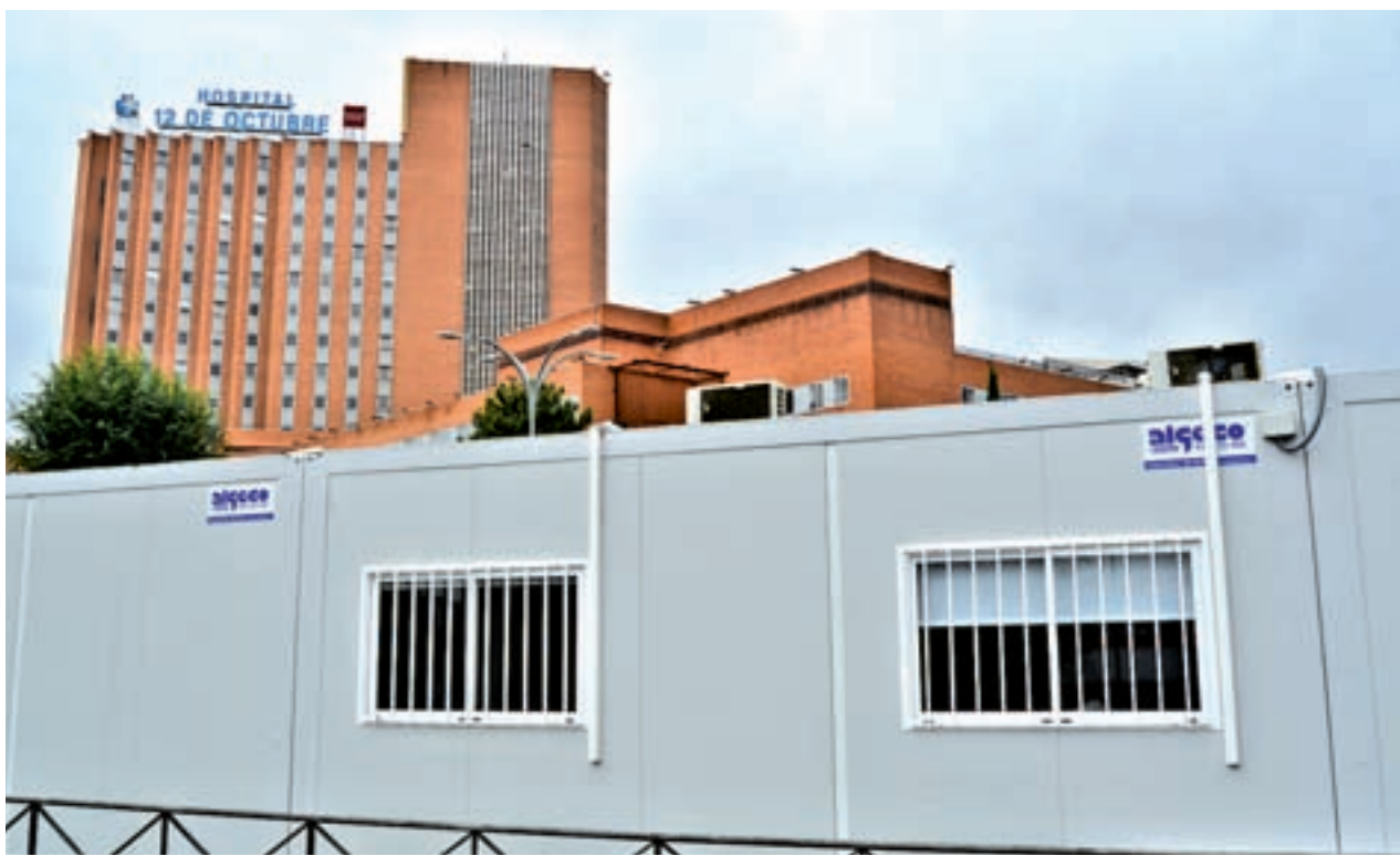
Estado actual del centro hospitalario situado en la avenida de Córdoba PEPE RIOFRÍO / GENTE
