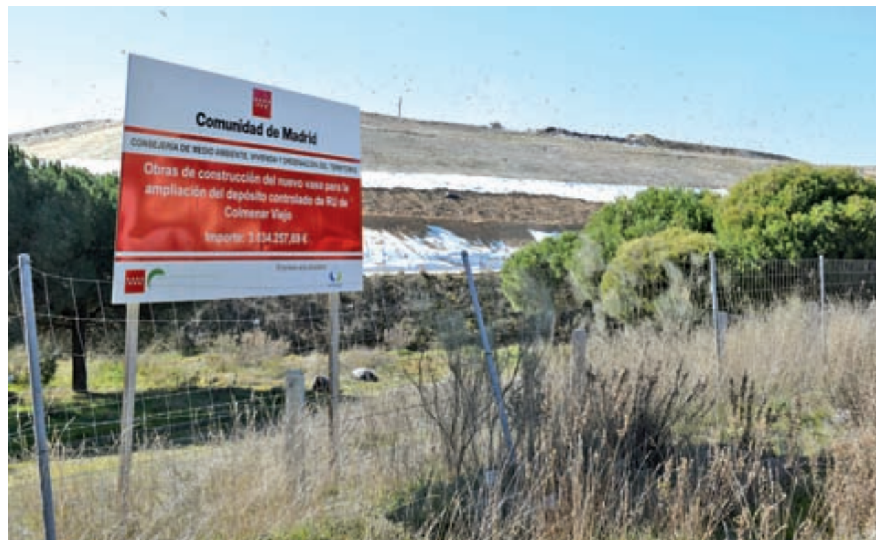
Estado actual del vertedero
