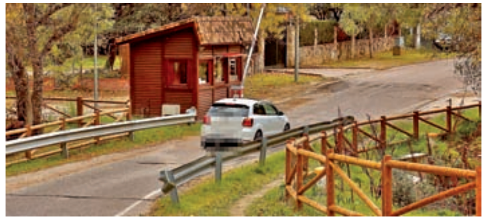
El Puente en Molino de la Hoz
