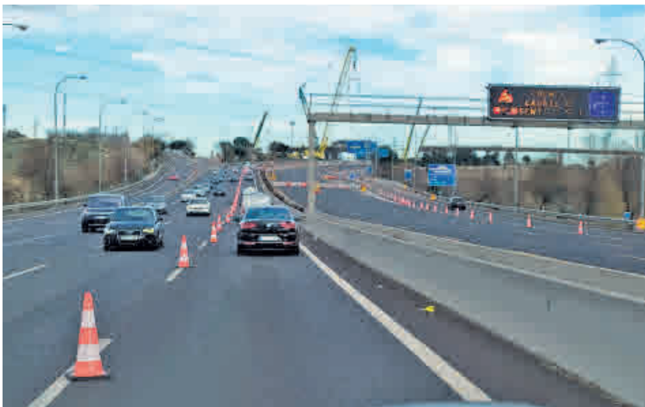
Trabajos en el viaducto CHEMA MARTÍNEZ / GENTE
