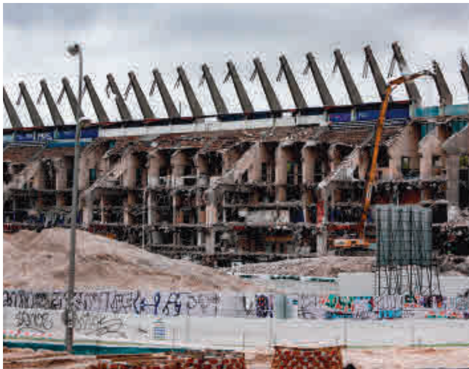
Obras de derribo del estadio Vicente Calderón
