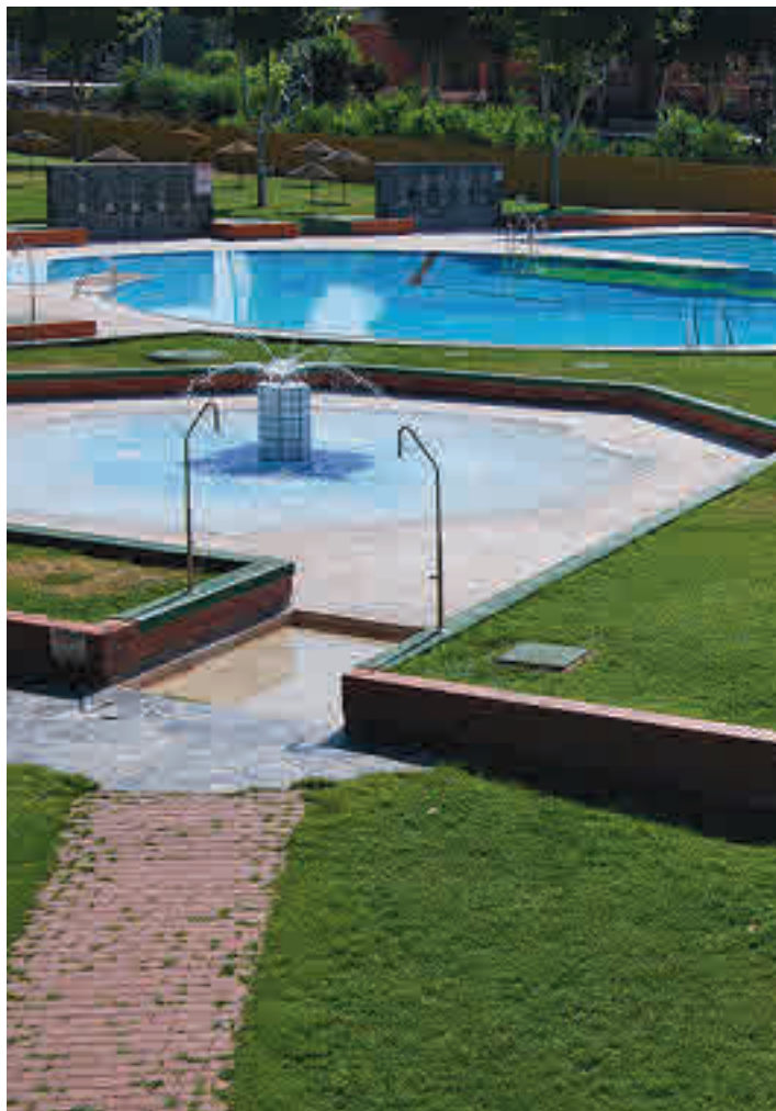
Instalaciones de El Juncal
