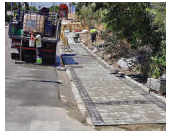
Los trabajos se realizarán durante julio y agosto
