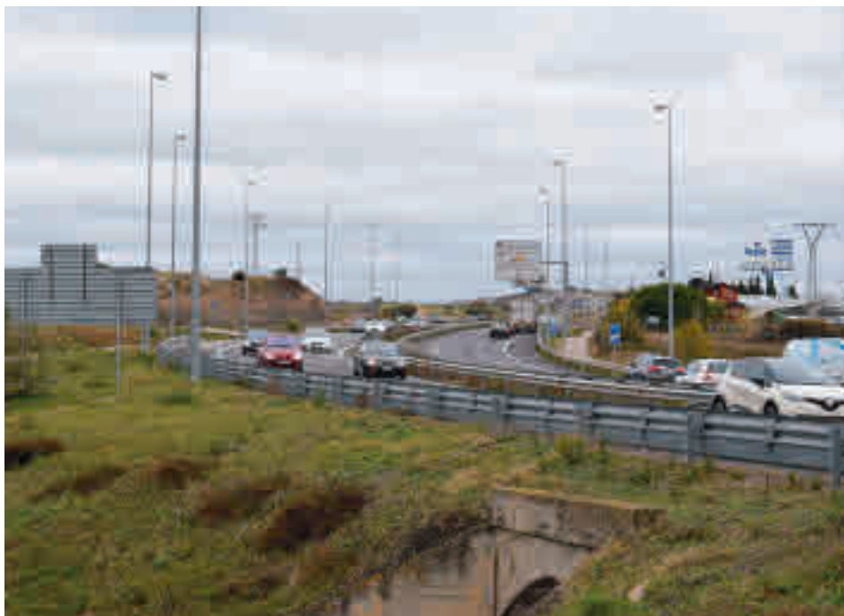
Tramo de la carretera M-607 entre Colmenar y Tres Cantos
