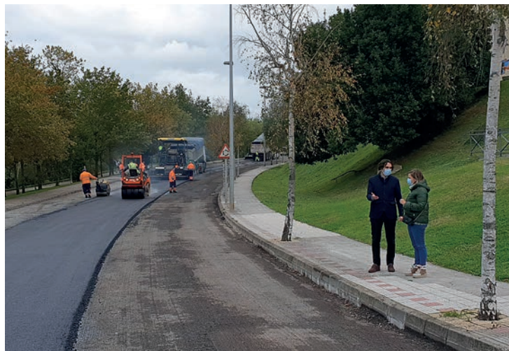
El alcalde, Javier Fernández Soberón, visitó las obras.
