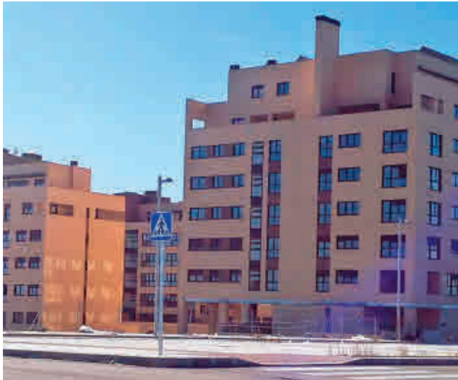
Una promoción de viviendas en construcción en el barrio de El Cañaveral
