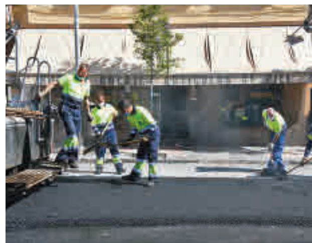
Operarios extienden asfalto en una calle de la capital
